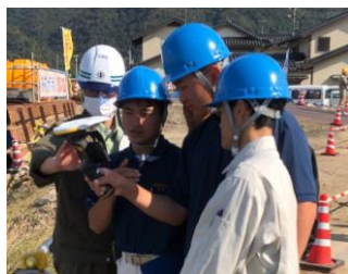
②ARによる現場説明
