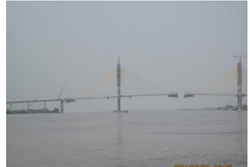
完成間近のネアックルン橋
