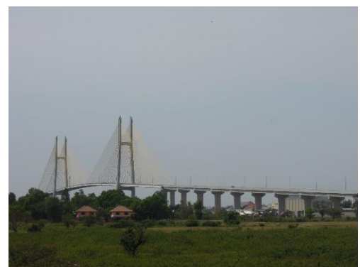
(ネアックルン橋)
