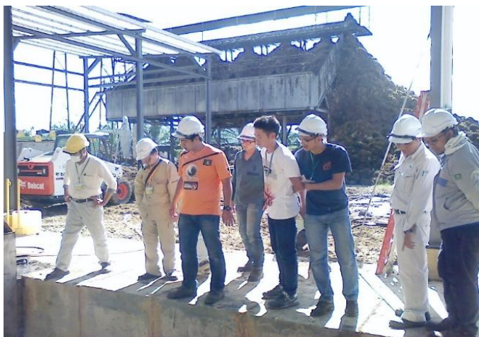
マレーシアでの炉の建設風景 (山本粉炭工業提供)
